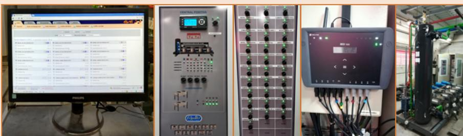
Desde el sistema **TelevisGO** ubicado en la sala de máquinas se realiza un análisis de las temperaturas de los muebles frigoríficos (**RTX600/V**) y en función de las mismas se calcula el set de evaporación óptimo que garantiza el máximo ahorro energético y el cumplimiento la cadena de frío. Desde el **TelevisGO** se escribe el set flotante óptimo en todo momento y en caso de fallo la central de compresores trabaja de modo normal gracias a la función back-up del controlador **EWCM 9100 eo**.
